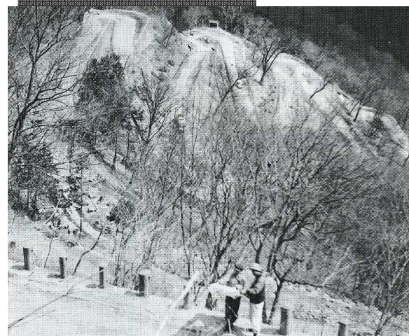
建設中のいろは坂
