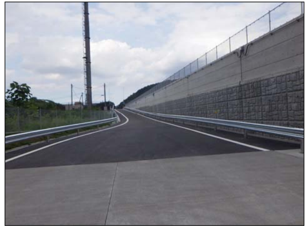
写真-1 アンテナ施設付近完成写真
