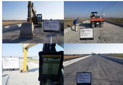
【ICT建機による置換工 (有効層)】
