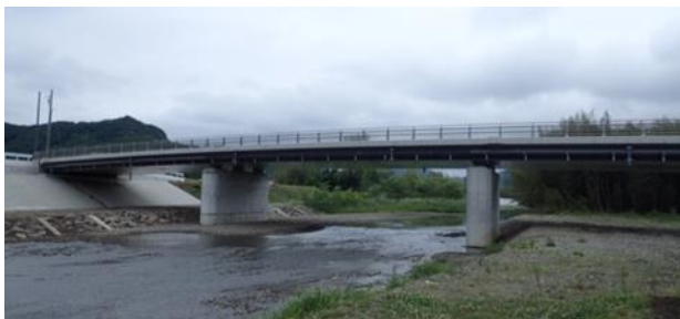
写5 新千塚橋竣工
