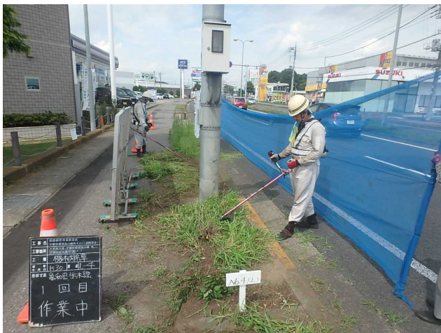
図-3 除草の様子（肩掛け式草刈機）
