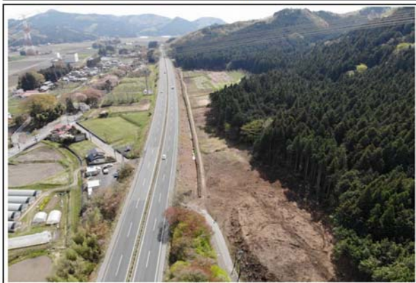
平成30(2018)年4月13日時点：樹木の伐採が完了しました。
