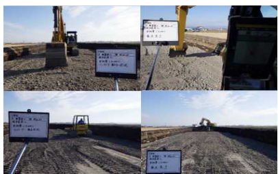
【ICT建機による置換工 (無効層)】
