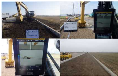
【ICT建機による盛土状況】
