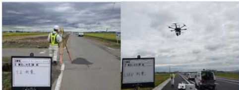
【UAVによる起工測量】
