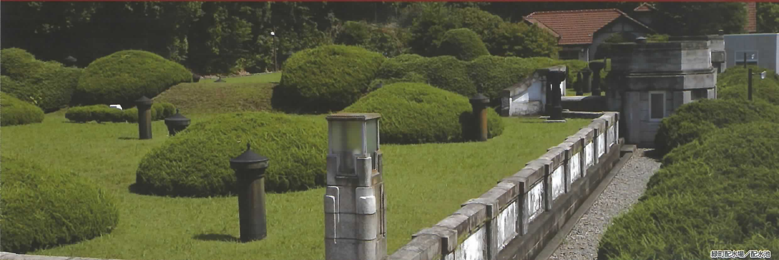
緑町配水池/配水池
