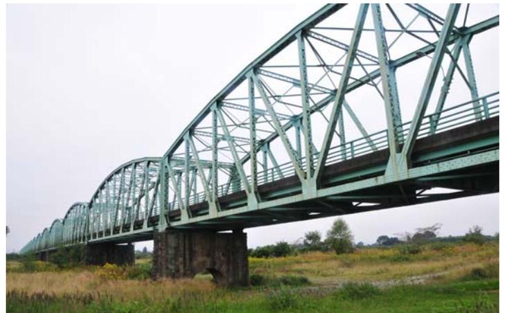
橋脚は、煉瓦円形ウェル2基の上に迫石により補強されたアーチ状の開口部をもつ切石積み構造であり、美観とともに堂々とした風格が漂う。また、橋門構上部には、4個の円形の開口部が左右対称にデザインされており、特徴的である。
