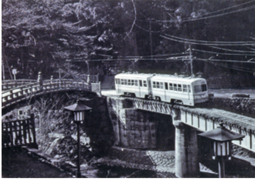
手前が仮橋 奥が神橋
